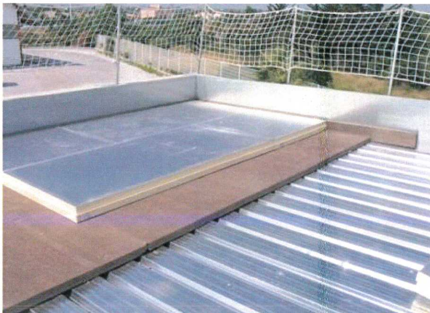
Photo : Pose de l'EuroTAN avec écran thermique perlite sur TAN
